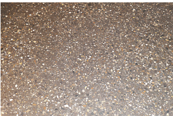
Betonterrazzo; Schleifen, Versiegeln, Veredeln
